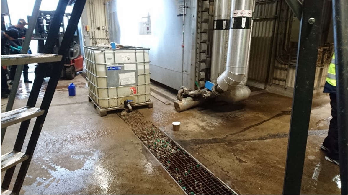
Figur 7. Exempel 2 på provtagningspunkt för substratslurry i anläggning A.
