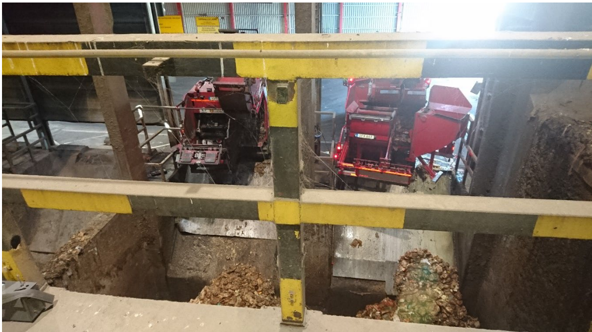
Figur 4. Mottagningshall anläggning C.
