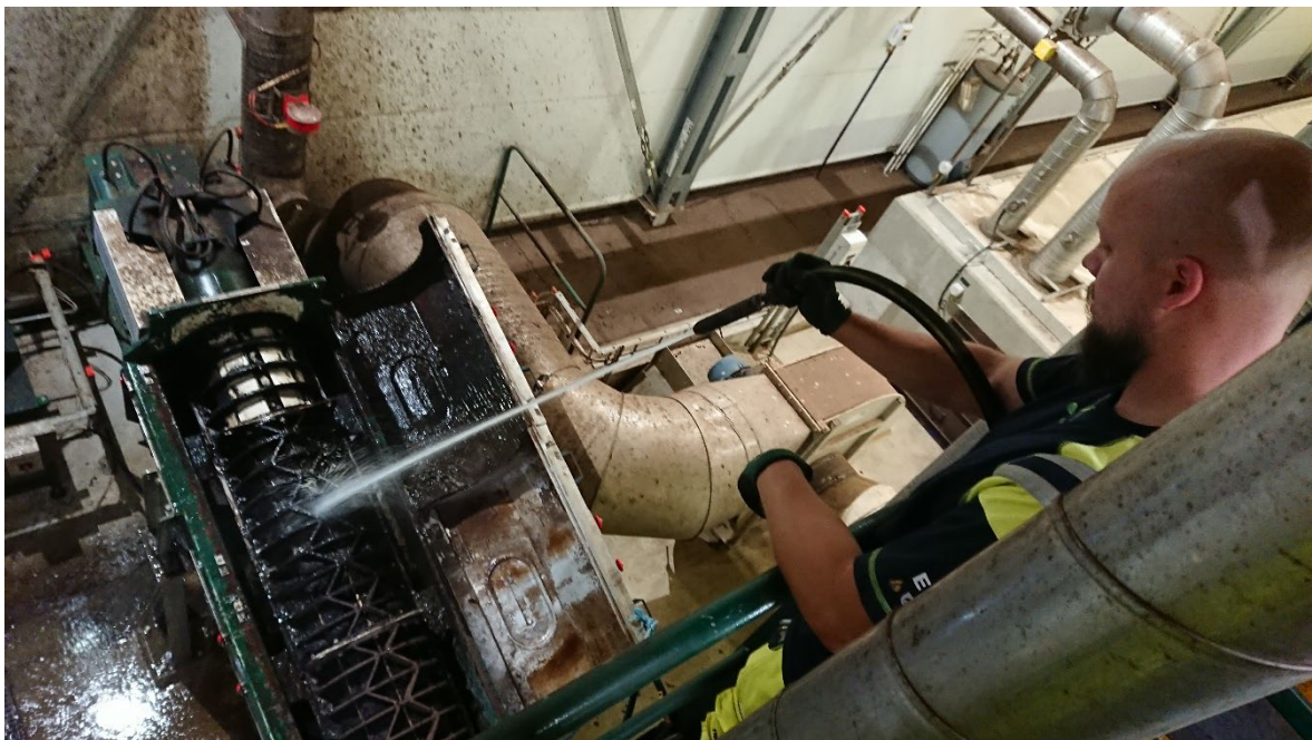
Figur 17. Underhållsarbete vid efterbehandling av biogödsel vid anläggning B.
