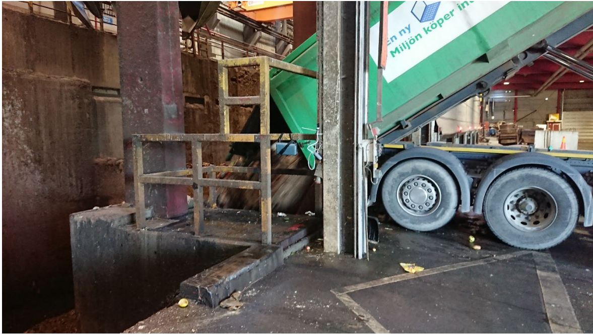
Figur 5. Mottagningshall anläggning C invid lossningsplatsen.
