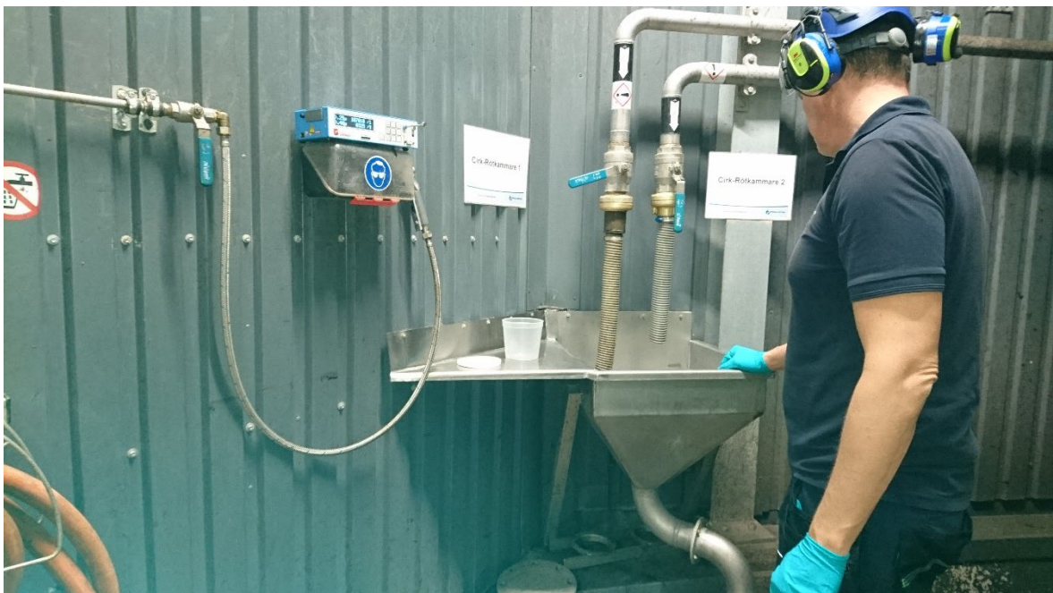
Figur 6. Exempel 1 på provtagningspunkt för rötmassa i anläggning A.
