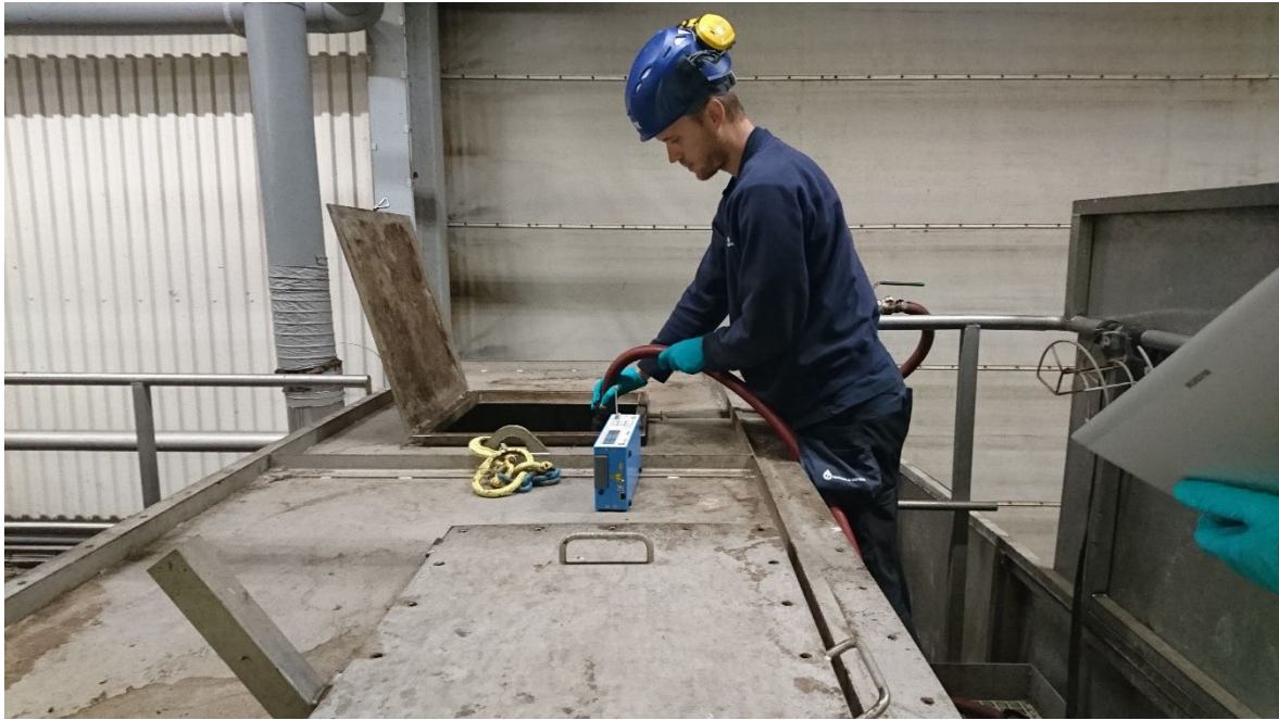
Figur 11. Underhållsarbete förbehandling vid anläggning A.
